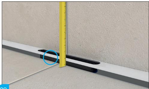
20 De nodige inkorting van de roosterhals opmeten. / Mesurez ensuite de combien le col de la grille doit être raccourci. / Dann messen Sie, wie viel der Gitterhals gekürzt werden muss. / Measure the necessary shortening of the grating neck.
