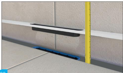
22 Diepte opmeten om het rooster de nodige ondersteuning te voorzien aan de hand van roosterblokjes. / La profondeur doit ensuite être mesurée afin de fournir le support nécessaire à l'aide des blocs appropriés. / Anschließend muss die Tiefe gemessen werden, um mit den entsprechenden Blöcken die nötige Unterstützung zu bieten. / Measure the depth to provide the grating with the necessary support using grating blocks.
