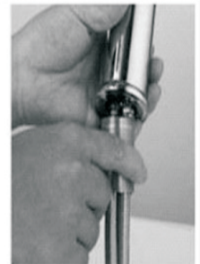
3, Tigten the lap and back nut
